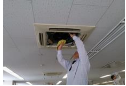
部署ごとにエアコンフィルターの 清掃を定期的に行っています（札幌）
