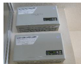
モジュール設置
